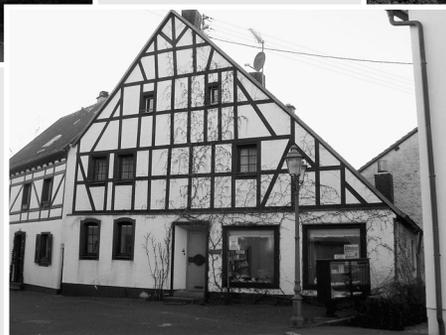
Abb. 12: Breitgiebelhaus mit angeschlepptem Anbau, massiv gemauertem Erdgeschoss und Fachwerkaufbau
