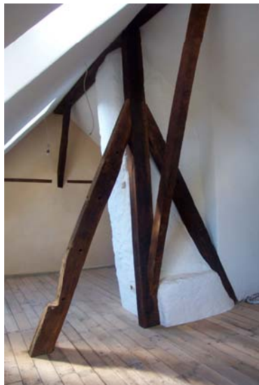
Abb. 11: Dachstuhl im ausgebauten Speicher - Auaust 2004
