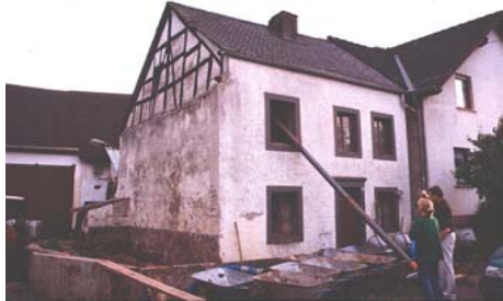
Abb. 1: Mehren, Steiningerstrasse 30. Das zweistöckige Haus mit einer Fassade aus dem Ende des 19. Jahrhunderts vor dem Beginn der Renovierung (Sept. 1999).
