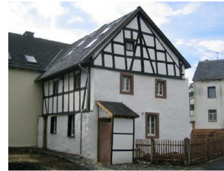
Abb. 2: Fachwerk- und Massivbauweise aus dem Jahr 1608 (renovierter Giebel und südl. Traufe, August 2004).
